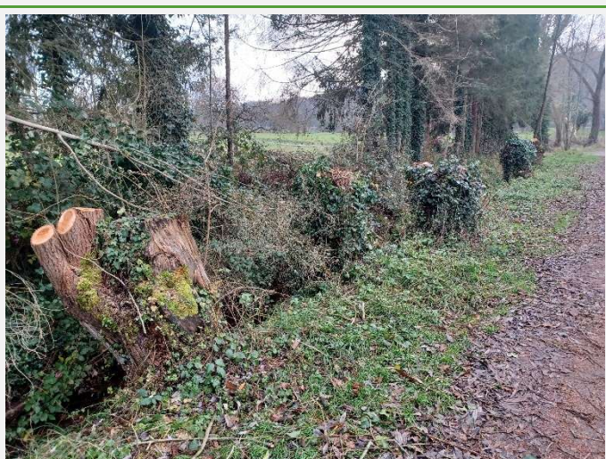
Décembre : Travaux d'entretien des boisements de berge Etêtage de Saules le long du Weidasch à Boersch
