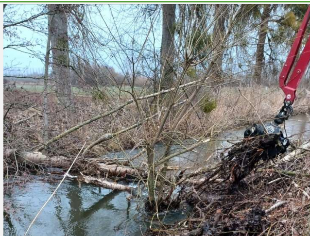
Février : Surveillance des ouvrages, gestion des embâcles, entretien des boisements de berge et travaux pluriannuels. Dégagement d'un embâcle sur l'Andlau à Westhouse
