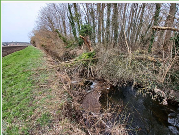
Avril : Surveillance des ouvrages, gestion des embâcles, entretien des boisements de berge et travaux pluriannuels. Embâcle sur l'Ehn à Blaesheim
