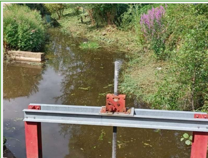
Juillet : Gestion des ouvrages / Travaux de fauche, dégagements d'embâcles et suivi des étiages Entretien des berges de la Kirneck à Gertwiller
