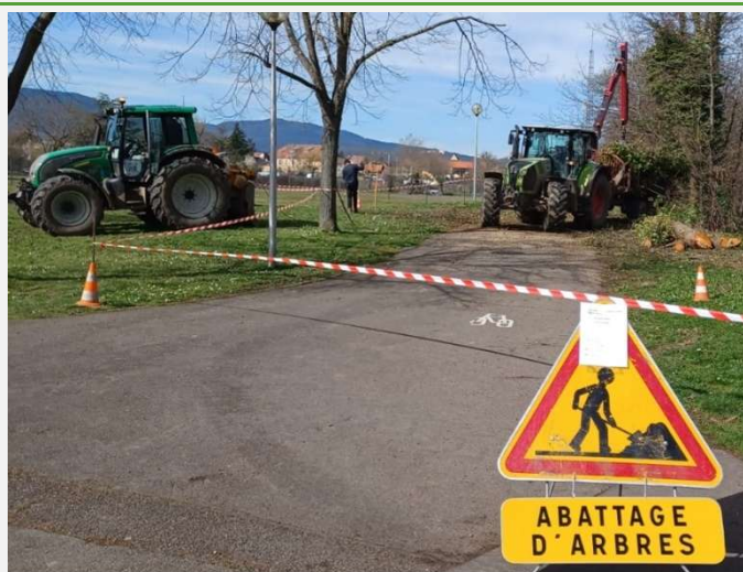
Mars : Surveillance des ouvrages, gestion des embâcles, entretien des boisements de berge et travaux pluriannuels. Abattage sanitaire le long de l'Ehn à Obernai
