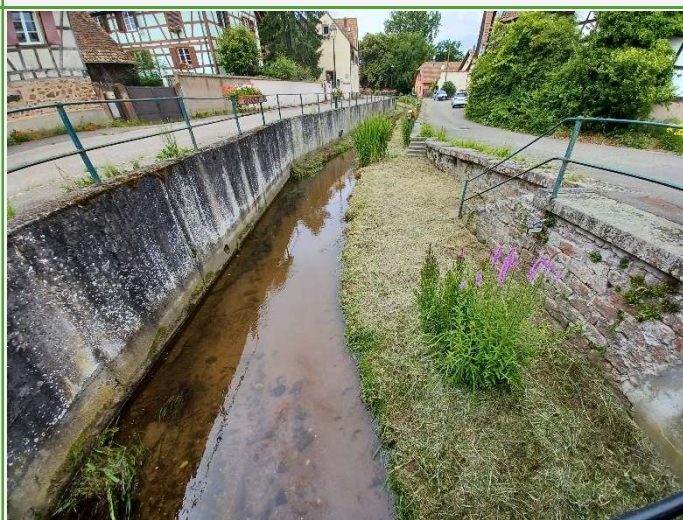
Juin : Surveillance des ouvrages, Gestion d'embâcles et travaux de fauche de printemps Fauche de la Kirneck à Bourghheim
