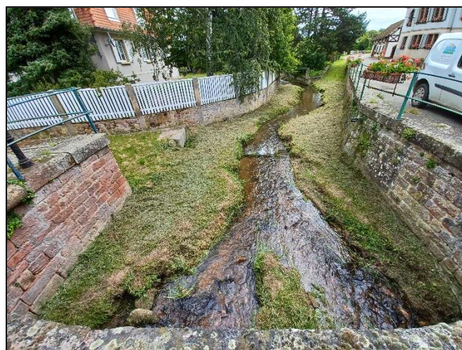
Travaux de Fauche à Bourgheim
