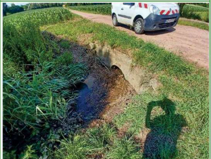
Juin : Surveillance des ouvrages, Gestion d'embâcles et travaux de fauche de printemps Gestion d'embâcles sur le Rosenmeer à Rosheim
