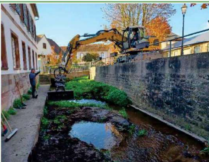
Octobre : Entretien des lits d'écoulements / Travaux de fauche Décapage des banquettes de la Kírneck à Barr
