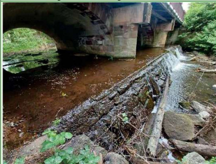
Mai : Surveillance des ouvrages, Gestion d'embâcles, Travaux de Fauche Contrôle de l'ouvrage de la RD 1422 à Saint-Pierre
