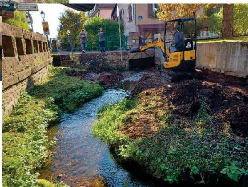
Travaux de décapage de banquettes sur le Muehlbach à Boersch
