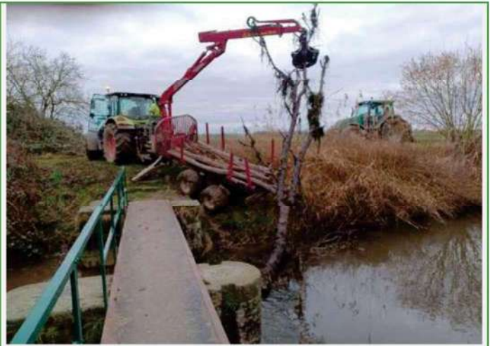
Février : Surveillance des ouvrages, gestion des embâcles, entretien des boisements de berge et travaux pluriannuels. Gestion d'embâcles sur l'Andlau à Lipsheim / Ichtratzheim
