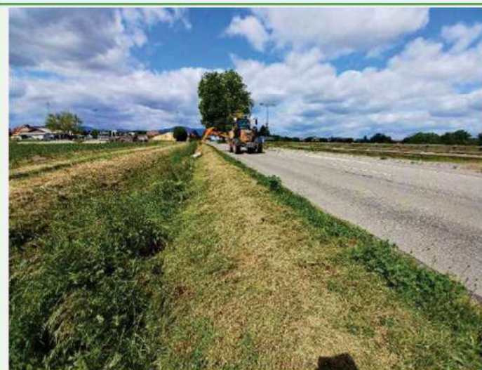
Septembre : Entretien des lits d'écoulements / Travaux de fauche, suivi des étiages Fauche du fossé de décharge de l'Ehn à Meistratzheim
