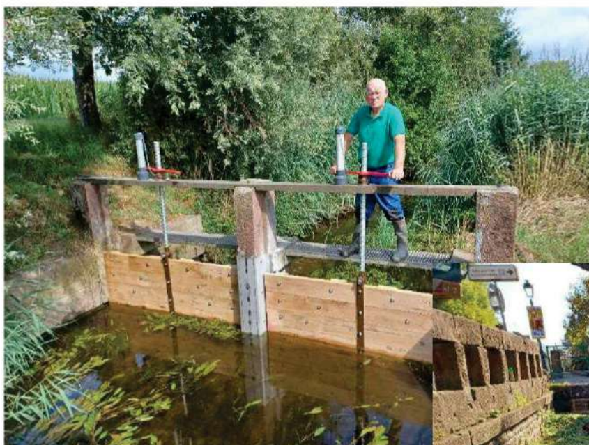
Restauration des vantaux d'un ouvrage de la Petite-Ehn à Krautergersheim
