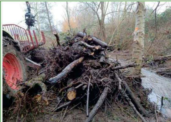
Janvier : Surveillance des ouvrages, gestion des embâcles, entretien des boisements de berge et travaux pluriannuels. Gestion d'embâcles sur la Kirneck à Gertwiller
