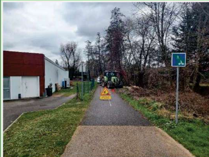
Mars : Surveillance des ouvrages, gestion des embâcles, entretien des boisements de berge et travaux pluriannuels. Abattage sanitaire le long de l'Ehn à Obernai
