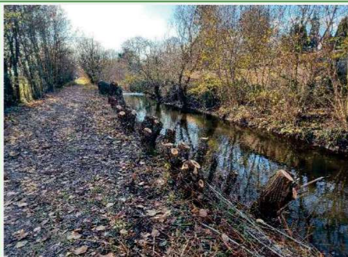
Novembre : Travaux d'entretien des boisements de berge Recépage de Saules le long de l'Andlau à Fegersheim
