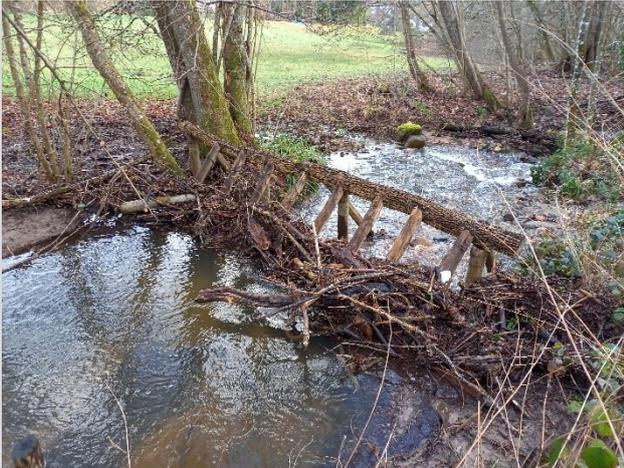
Dégagement d'un piège à embâcle lors des tournées de surveillance après les crues (ouvrage à Barr)
