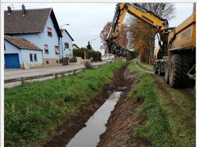
Novembre : Décapage des végétaux et évacuation des atterrissements sur le fossé de décharge de l'Ehn à Meistratzheim
