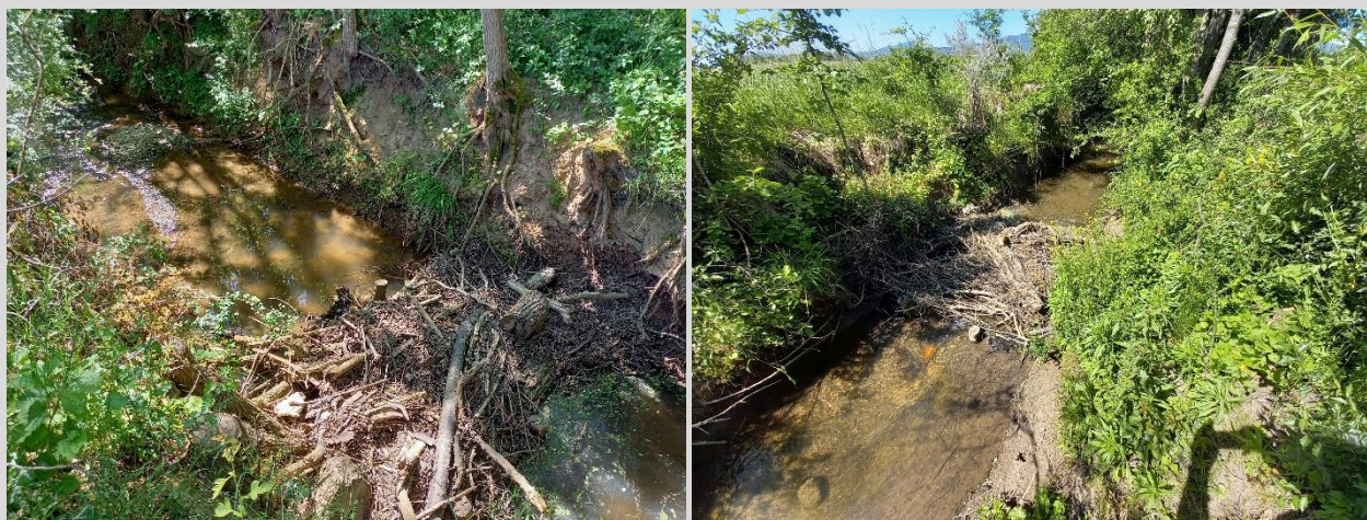
Réalisation d'une succession de 5 seuils dans le lit du Dachsbach
