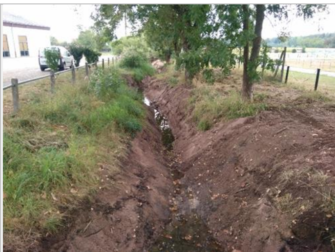
Août : Décapage d'un atterrissement sur la Kirneck à Valff
