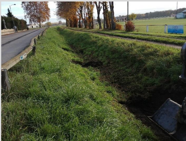
Trous de sondage au droit des ouvrages
