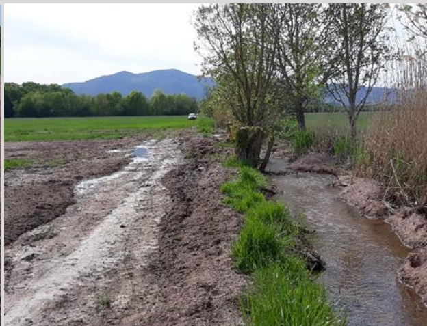
Décapage des sédiments déposés en Rive Droite sur le Chemin d'exploitation et création d'une annexe hydraulique vers la roselière
