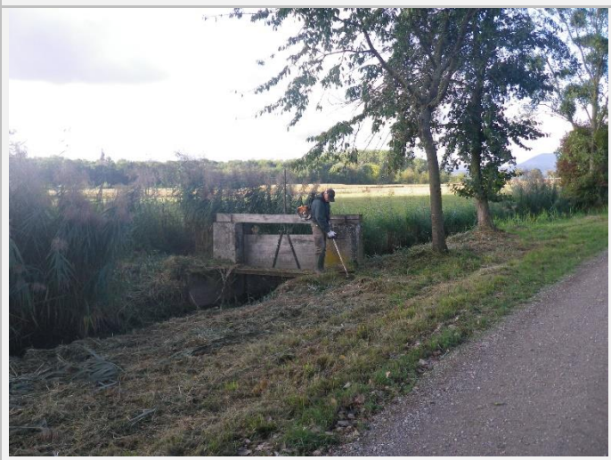
Octobre : Travaux de Fauche Mécanique (avec tracteur-épareuse) et Fauche Manuelle aux abords des ouvrages
