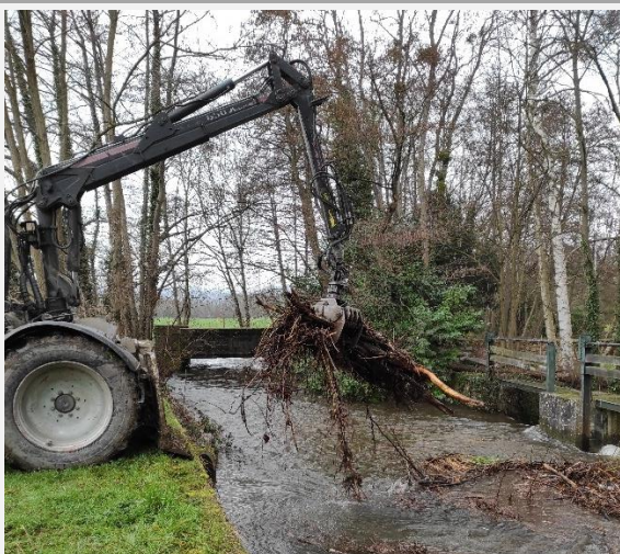
Janvier : Dégagement d'un embâcle formé au droit d'un ouvrage de l'Andlau à Saint-Pierre
