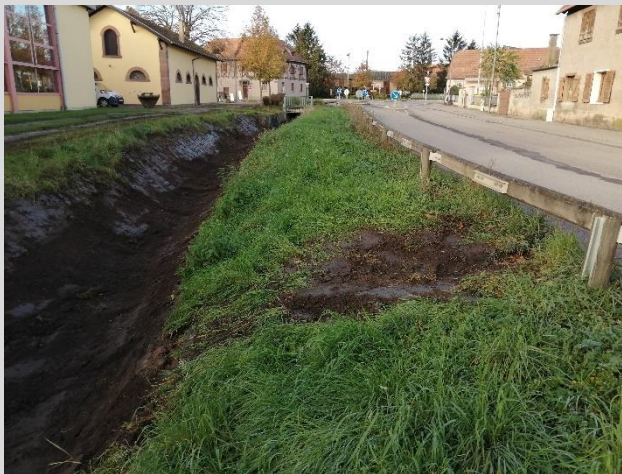
Décapage et Export des sédiments sortis du fossé
