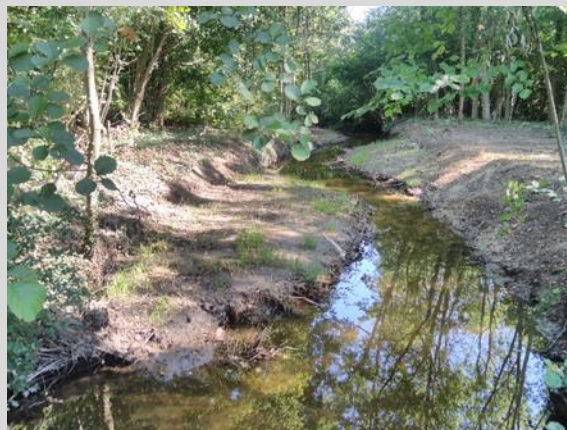
Vue des épis-peignes réalisés à l'issue des travaux
