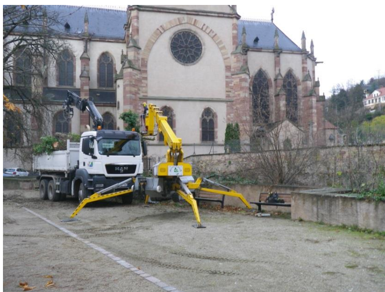
Démontage d'arbres vieillissants en zone urbaine
