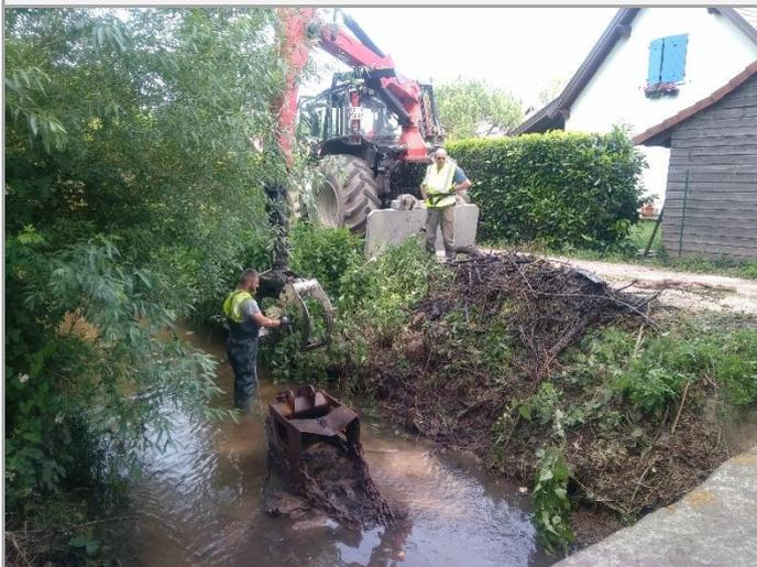
Mai : Réduction des dépôts de sédiments à Valff, au moyen d'une dragline
