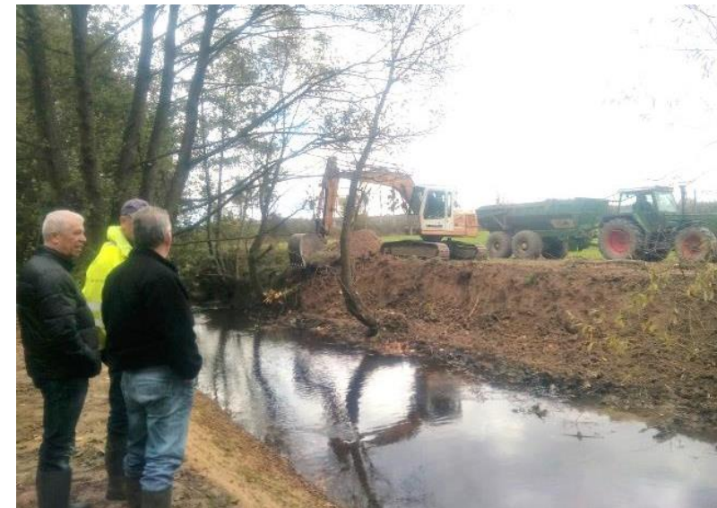
Des réunions de chantier hebdomadaires
