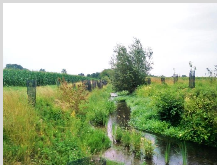
Berge entretenue, un an après les travaux de restauration de la Scheer (CC Canton d'Erstein)
