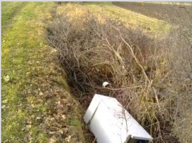
Abandon d'électroménager et de branchages dans le lit d'écoulement
