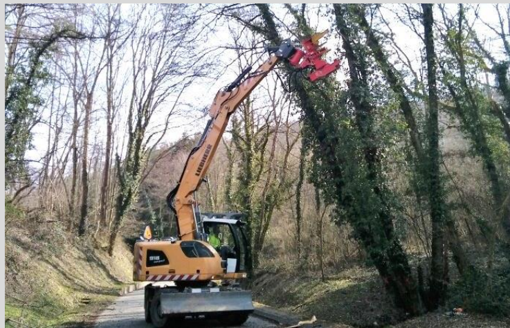
Recours à une pince d'abattage
