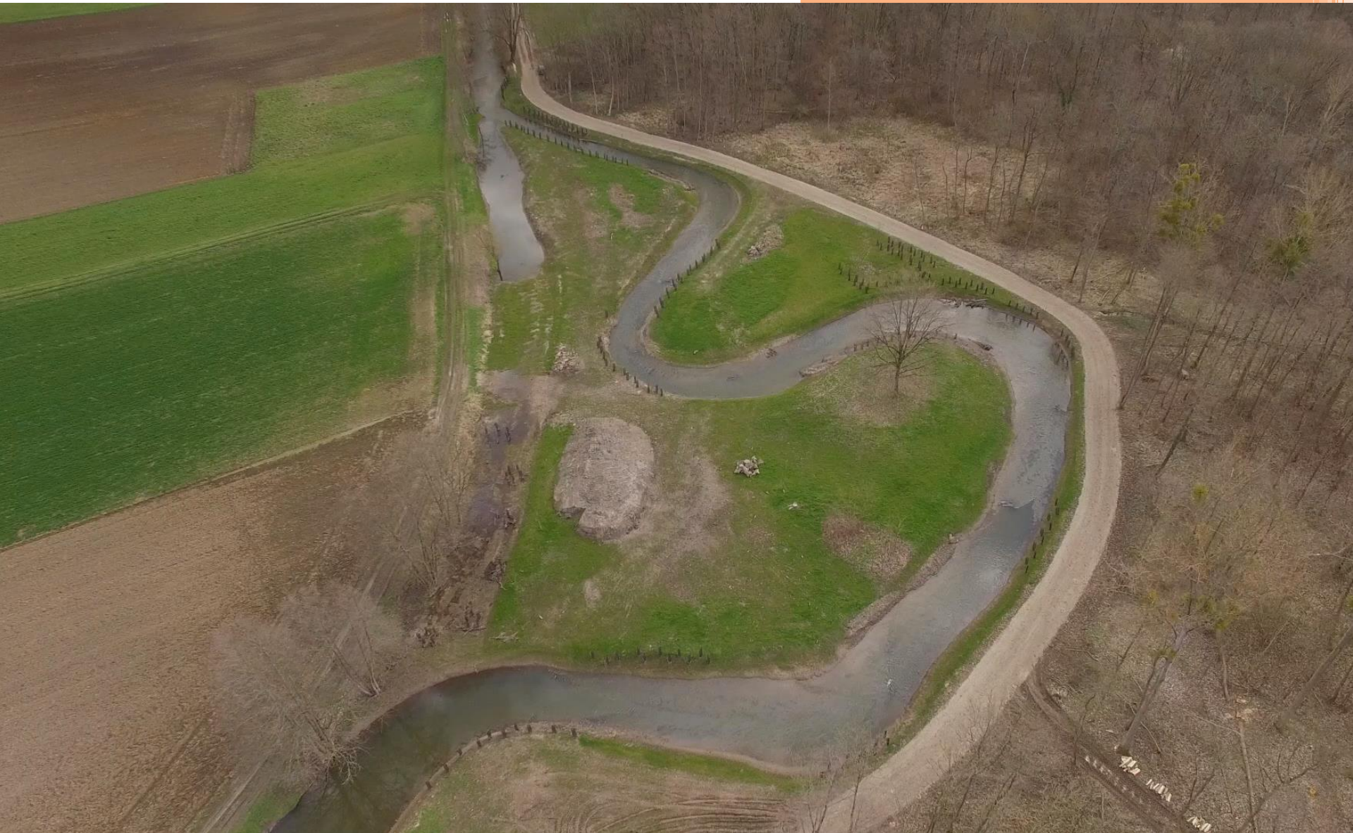
Vue aérienne - Renaturation de l'Andlau à Hindisheim ... Avril 2018 - Maîtrise d'ouvrage: CC Canton Erstein
