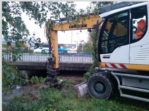
Décapage des sédiments en aval d'un pont sur l'Ehn à Obernai pour maintenir le gabarit hydraulique
