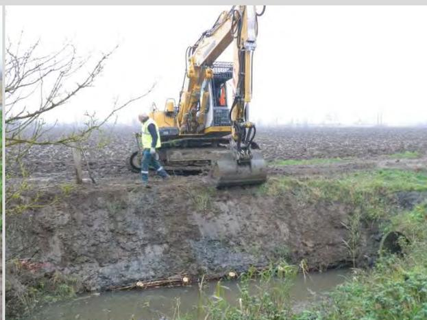
Pose d'un peigne en branchages en aval d'un ouvrage
